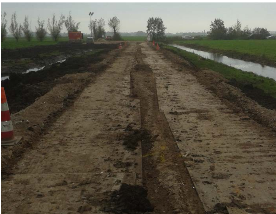
Bouwweg na stabilisatie.
