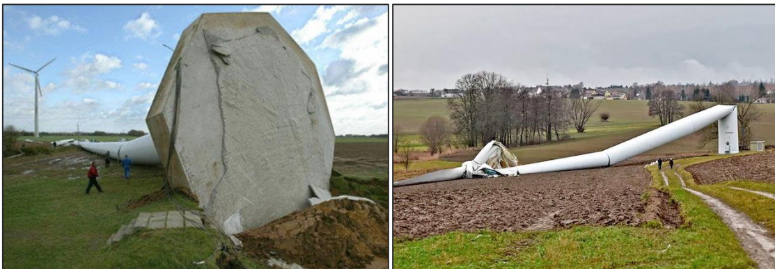
Figuur 4.2 Voorbeelden mastfalen rechts: masttoren falen en links fundatie falen
